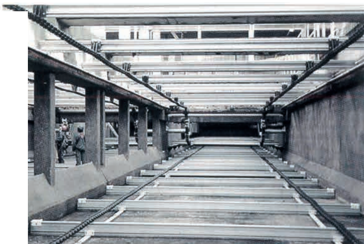
BELKI ZGARNIAJĄCE HMAX Z ALUMINIUM MOGĄ BYĆ STOSOWANE Z ŁAŃCUCHAMI Z TWORZYWA, ZE STALI NIERDZEWNEJ ORAZ ZE STALI CIĄGLIWEJ*
